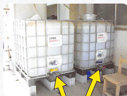
アルミ缶洗浄用雨水タンク
