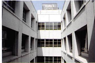
自然光を採り入れる校舎
